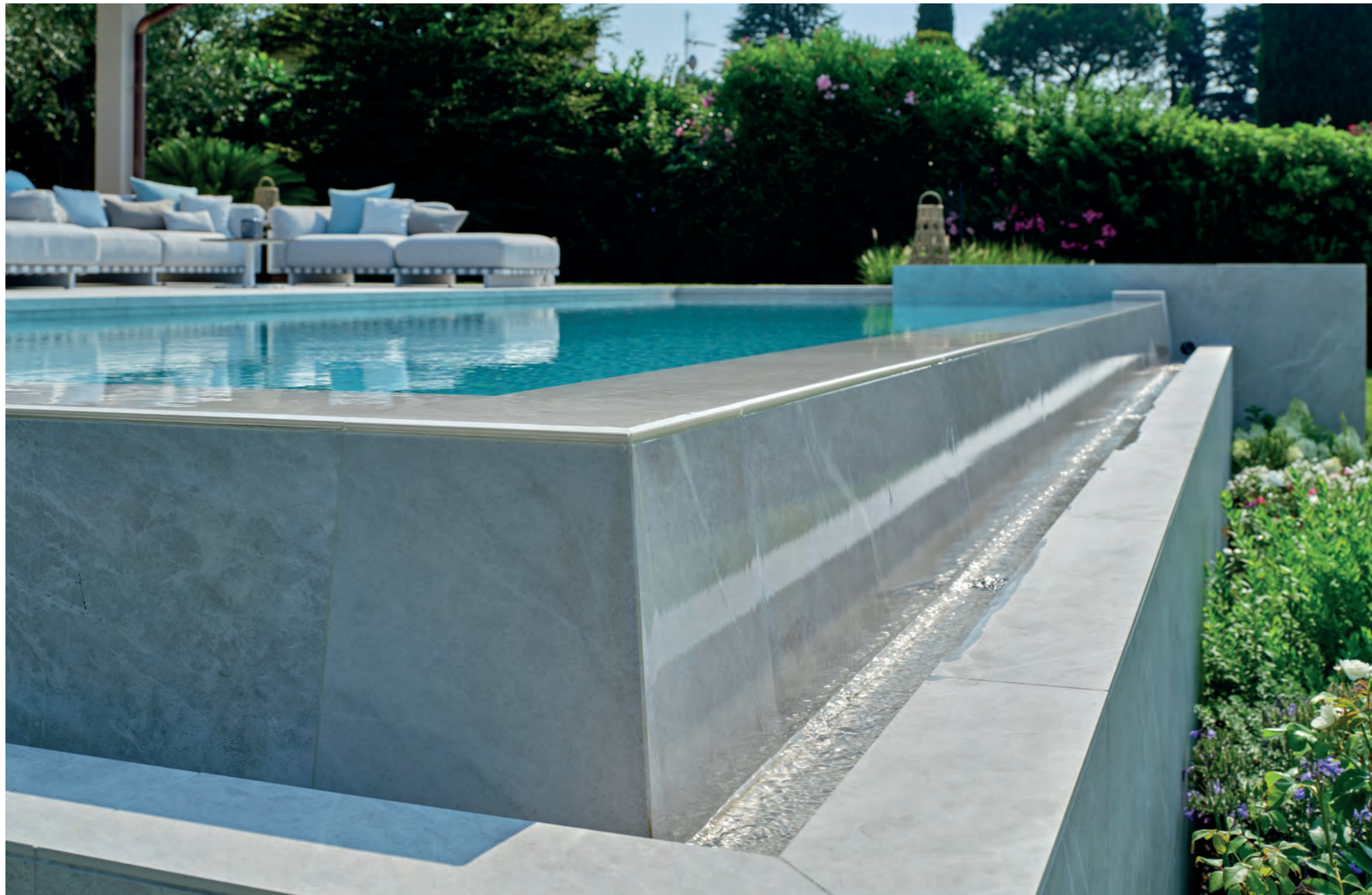
Gut zu erkennen ist, wie das Oberflächenwasser über die Infinity-Rinne des edel gefliesten Beckens in den Wasserspeicher läuft.
