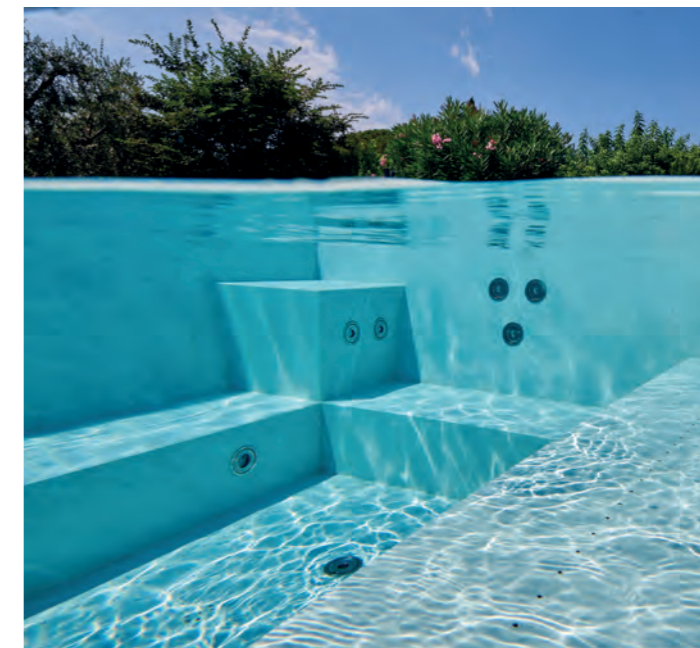
Ein Blick in den Whirlpool: Insgesamt 182 Löcher musste der Fliesenleger für die Whirldüsen in das Steinzeug bohren und um die Massagestation, die Sensortaster und die LED-Scheinwerfer einbauen zu können.
